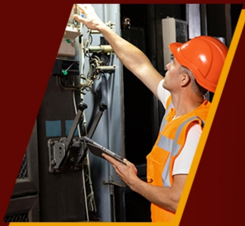
EMPRESAS DE MANUTENÇÃO DE ELEVADORES
